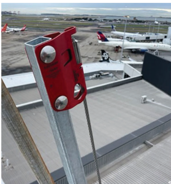
Hệ Thống Dây Cứu Sinh Phương Ngang
