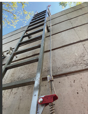
Hệ Thống Dây Cứu Sinh Trên Thang (VLL)
